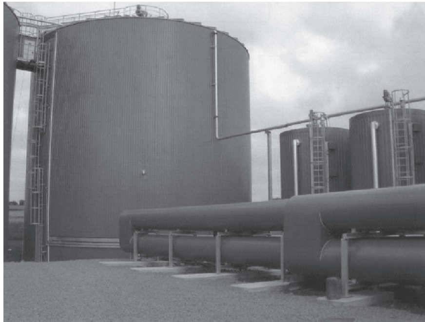
Fig.: 12.7 Anaerobic Digester
